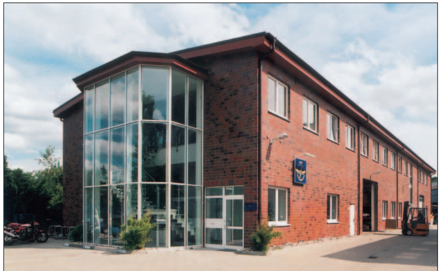
Beispiel 3: Einsatz des ecopower in einem Gewerbebetrieb (Tischlerei)
