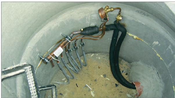
Abb.: Direktverdampfung ohne EVR-Technologie
