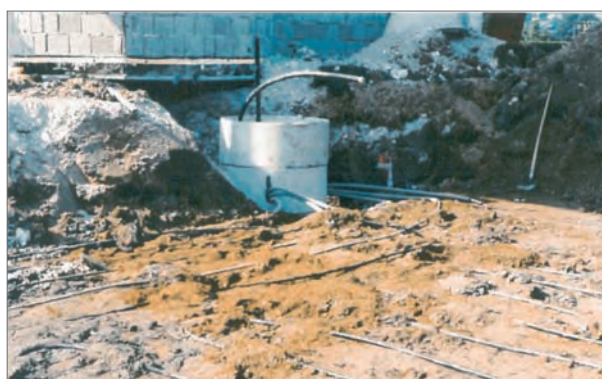
Abb.: Zuführen der Kollektorrohre zum Verteilerschacht
