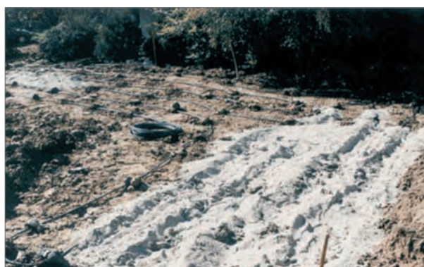
Abb.: Beispiel für das Verlegen eines Flächenkollektors
