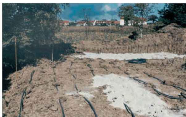
Abb.: Beispiel für das Verlegen eines Flächenkollektors
